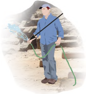
BAGNATURE SUPERFICIE DI SCAVO
